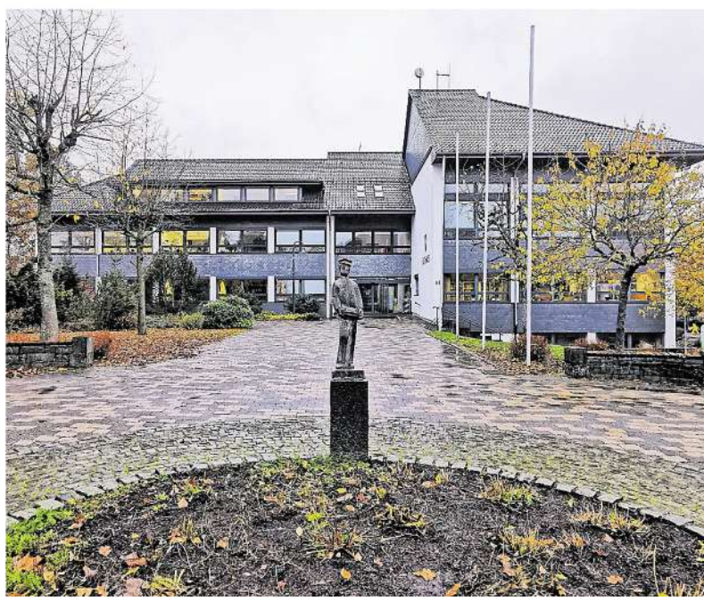
Das Rathaus in Roetgen: Nach einer ersten Beurteilung galt das Dach zunächst als wenig geeignet für eine Photovoltaikanlage. Diese Entscheidung möchte „Roetgen mach Watt!“ noch einmal überprüfen.
